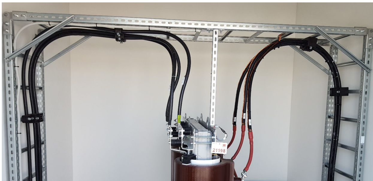
Obrázok 31 Pohľad na POK pre pripojenie káblov VN a NN na transformátor VLSP
