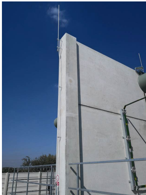
Obrázok 11 Ochrana stanovišťa transformátora pred bleskom
