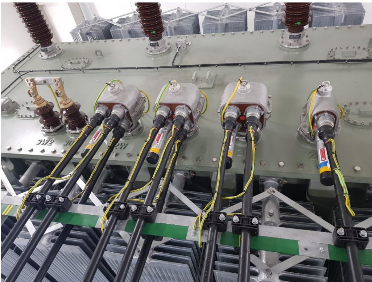
Obrázok 3 Vyvedenie výkonu – spôsob inštalácie zvodičov prepätia
