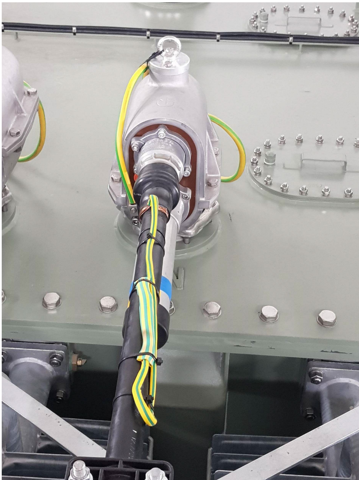
Obrázok 6 Pripojenie primárneho odporníka k T10x – tienenie kábla primárneho odporníka na strane T10x nepripojené
